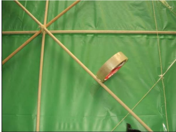
Figura 16. Pegado varillas de madera a revestimiento.
